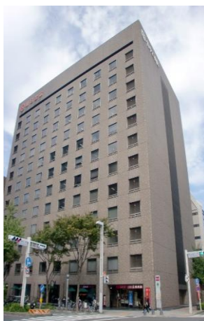
名古屋ATビル 2F
